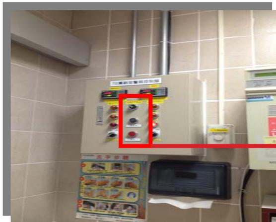
生物安全室內負壓控制電子儀表板加裝手動強制啟動風機開關
